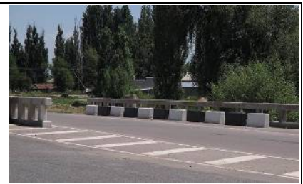
塗装・修復された ケンブルン橋の路肩
