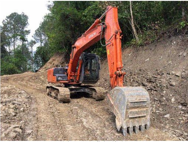
(建設中の農村道路)
