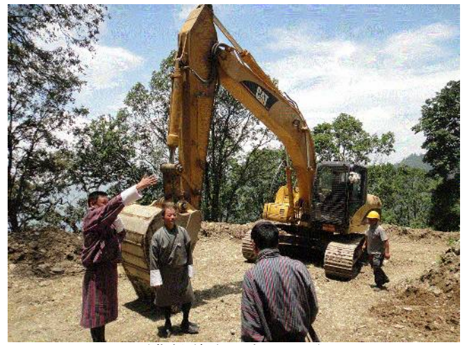
(農村道路の建設現場)
