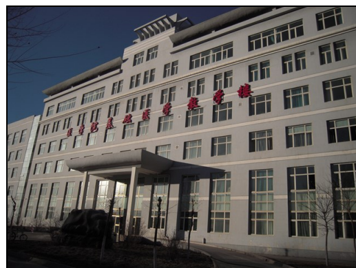
青海大学 医学院基礎医学教学棟
