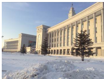
この建物の一部を追加アウトプットとして建設し、実験設備共用プラットフォームを設置した。 （ハルビン師範大学）
