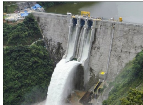
ピリス水力発電所 RCC ダム 2 (コスタリカ電力公社 (ICE) 提供)
