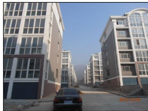
写真 3：常家村開発地域
