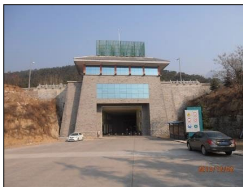
写真 1：泰安揚水発電所の地下発電所入口
