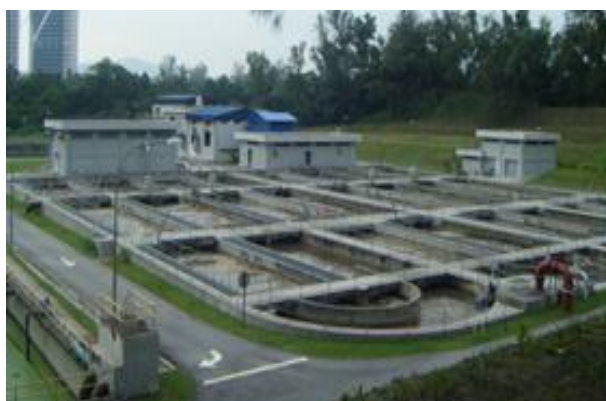
ダマンサラ下水処理場
