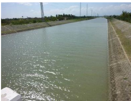
建設されたハロ放水路
