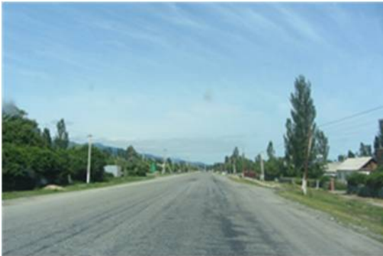
（ポットホルのパッチワーク作業後のインクリ州の道路）
