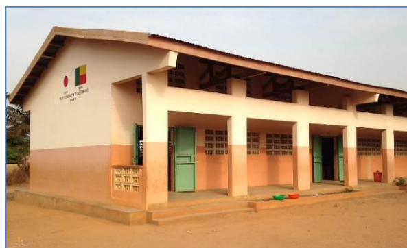
本事業で建設された教室棟 (ズー県 ソドホメ小学校)
