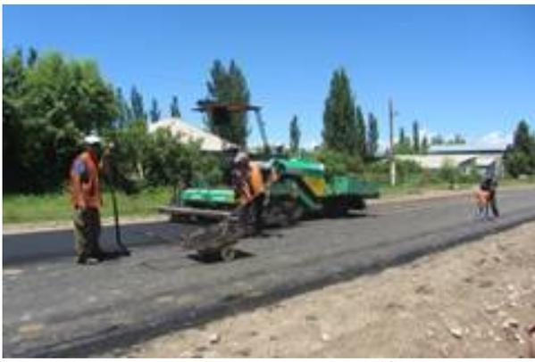
(イシクリ州でのアスファルト補修作業)
