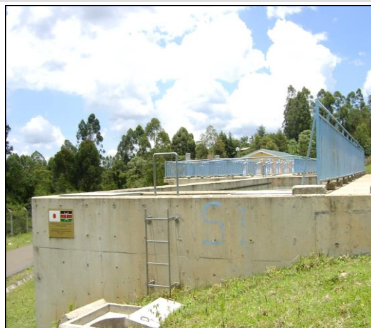
カプサベット市浄水場第1沈殿池
