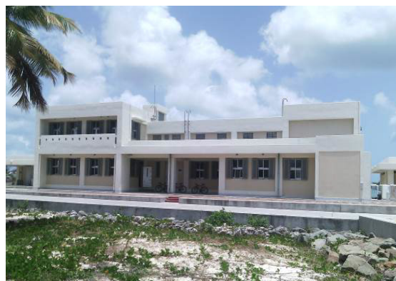
本事業によって整備された水産施設 (バーブーダ島コドリントン地区)
