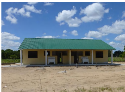
写真6 マンジャカゼ校の教員宿舎（建設中）
