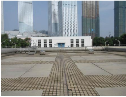
写真4 琅東下水処理場第2期 生物反応池
