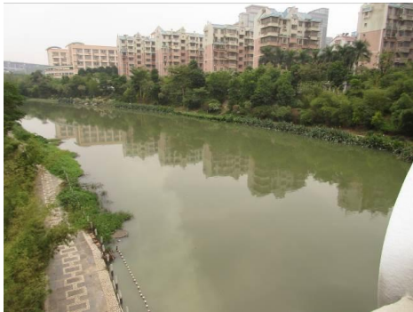
写真2 竹排水路の護岸
