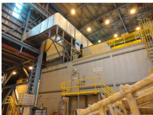
ガスタービンが入っている施設
