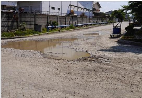
写真 17：破損で水たまりができています
