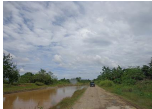
写真 2：ダムにつながる用水路 (事後評価時)
