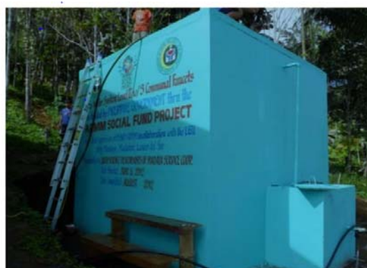
3 個の蛇口を持つ浄水システム 南ラナオ州マダラム
