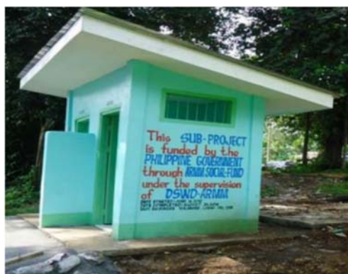
水道衛生施設 南ラナオ州マラバン
