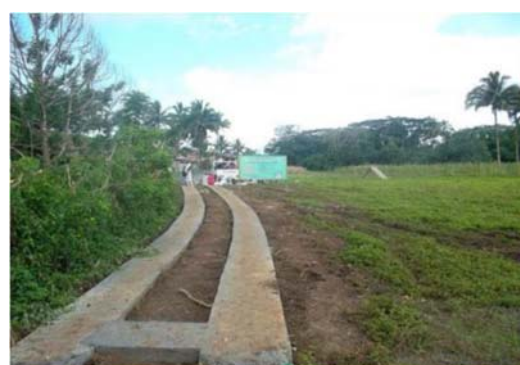
車輪走行帯舗装 南ラナオ州ツバラン
