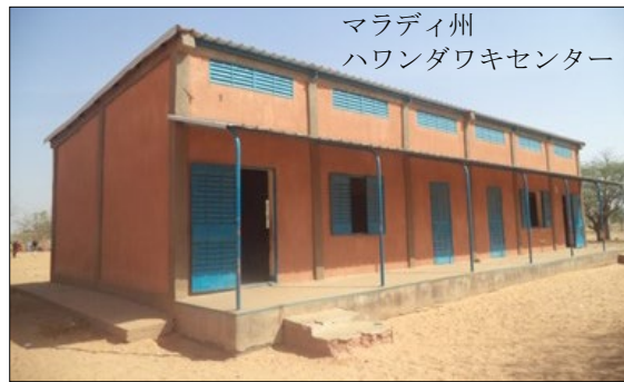
本事業により建設された学校
