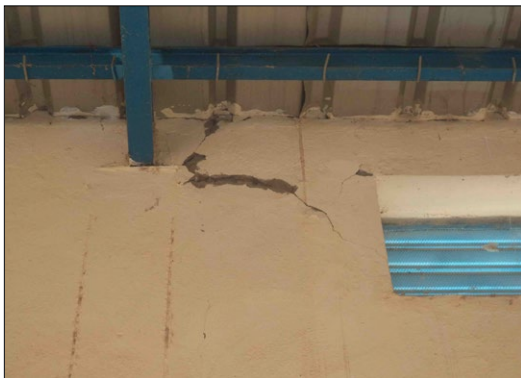
多くの教室の内壁に見られるクラック (マラディ州マヤヒ県カネンバカチェ校)
