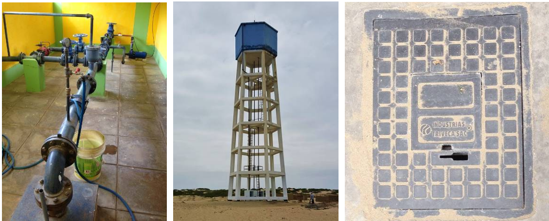
パイロット事業により建設された村落給水施設（左から）：井戸（ピウラ州ライナス村）、給水塔（ピウラ州サンパブロ村）、水道メーター・ボックス（ピウラ州サンパブロ村）
