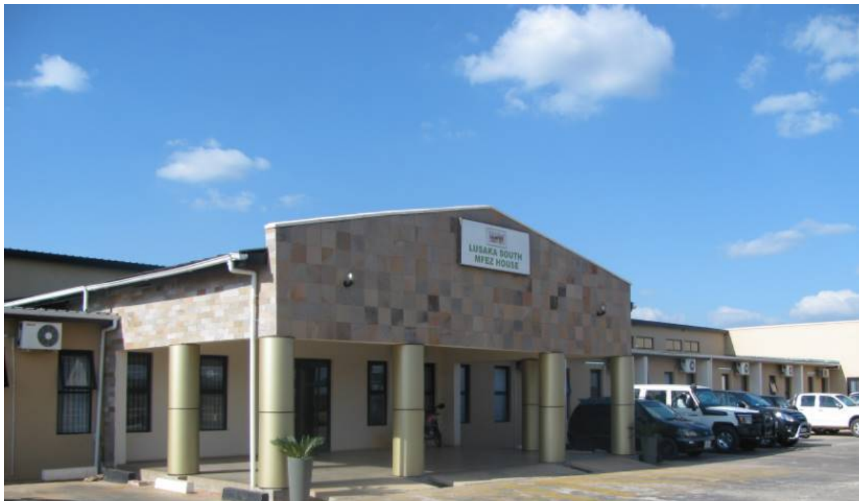
ルサカ南部マルチファンリティ経済区オフィスビル
