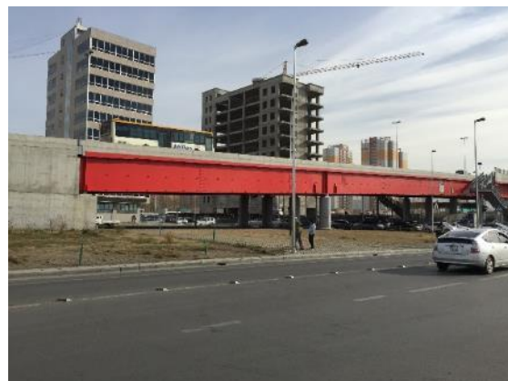
太陽橋北側のイフ・トイレー通り （事後評価時）
