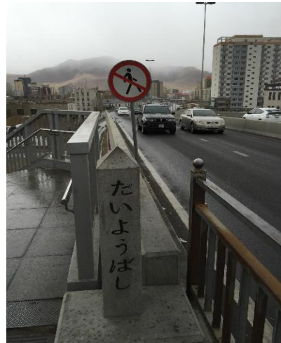
歩行者階段取り付け部の歩行者侵入禁止標識 (事後評価時)
