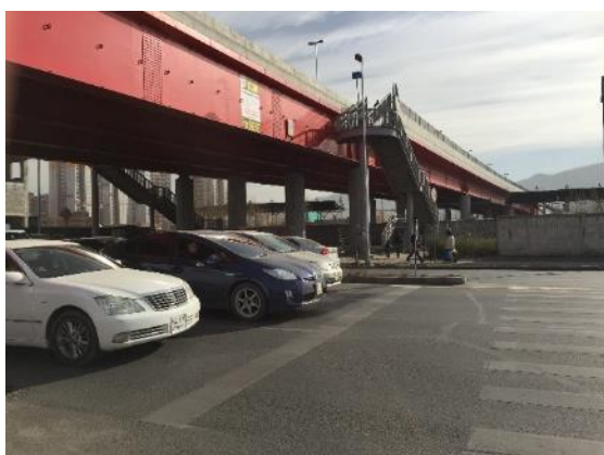
太陽橋下ナルニーザム通り 西側交差点の様子（事後評価時）
