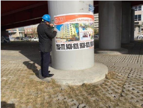
日常点検・清掃業務 張り紙を外している (事後評価時)
