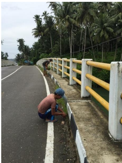
サウア橋でPPKの作業員が除草作業を行っているところ (事後評価時)
