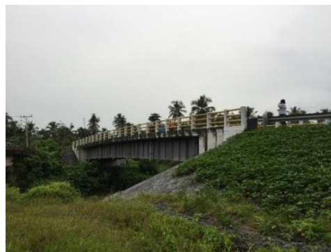
本事業によって整備されたギド・シイテ橋
