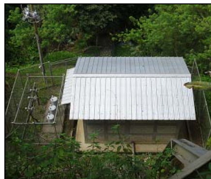
発電施設（セアシル） 写真手前から施設に入る管は水圧管
