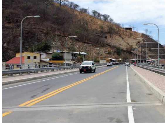
新橋（エクアドル側から撮影）
