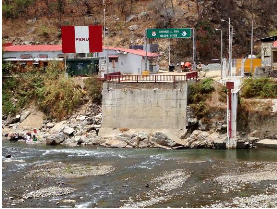
撤去された旧橋の跡（ペルー側）
