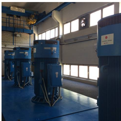
マレザ新ポンプ場の4台のポンプ
