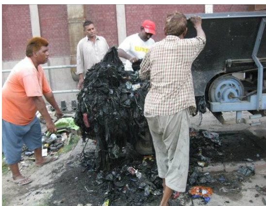
自動除塵機からのゴミの除去作業
