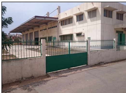
重機保守科の訓練棟施設
