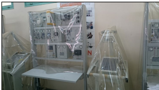
ソーラーパネル設置実習機材 (砂除けカバー使用中) (建築整備保守科)
