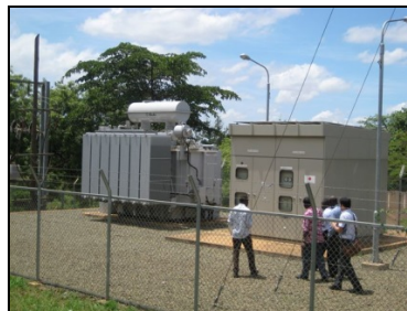
YMCA 変電所（更新）
