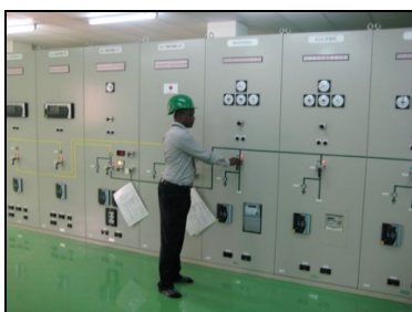
マクユニ変電所 建屋内
