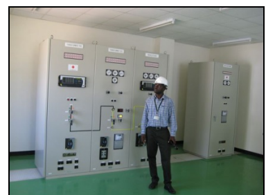
キユンギ変電所 建屋内
