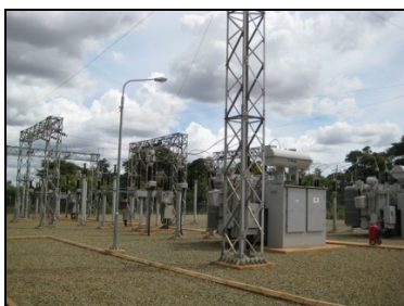
マクユニ変電所（新設）
