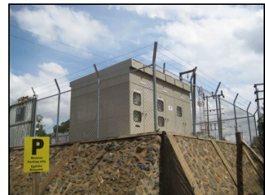
トレードスクール変電所（拡張）
