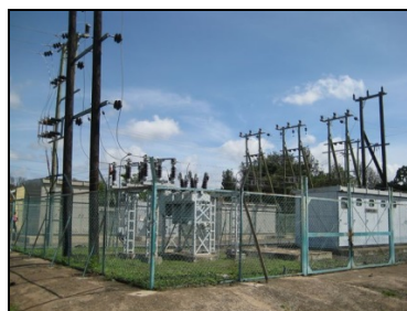
ラワティ変電所（更新）
