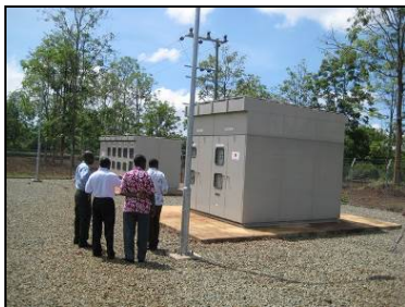
KCMC 変電所（新設）
