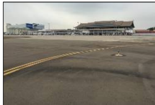
拡張された誘導路 (ビエンチャン国際空港)
