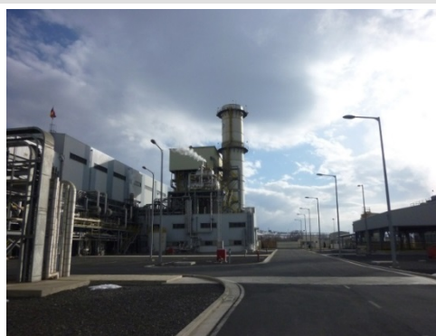
エレバン・コジェネレーション火力複合 発電所
