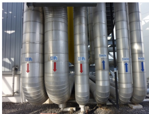
写真 4：熱供給配管
