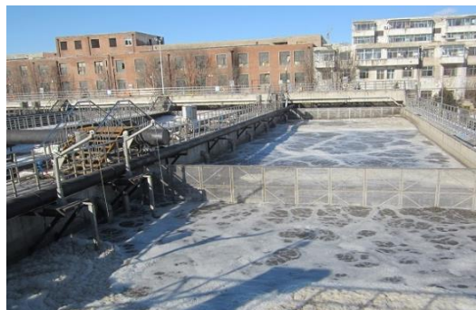
公主府下水処理場の生物反応槽
