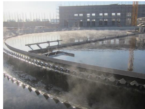
辛辛板下水処理場の沈殿池
