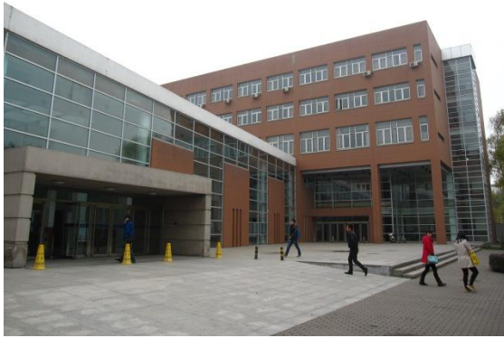
本事業で建設された教学棟 (山西大学)
