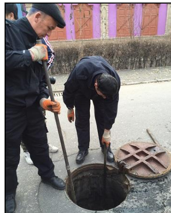
下水管のメンテナンス作業
