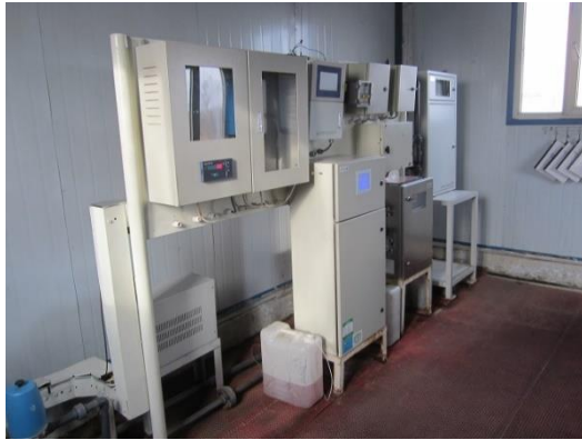
松浦下水処理場の水質モニタリング装置
