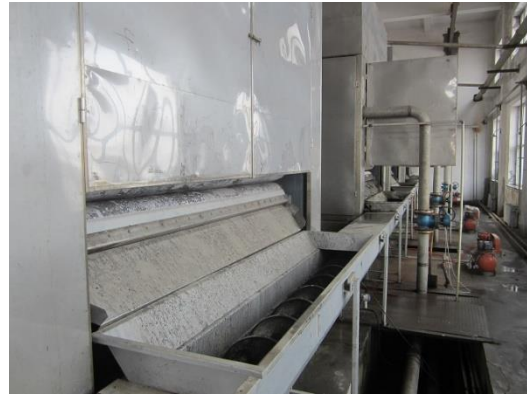
平房下水処理場の汚泥処理施設
