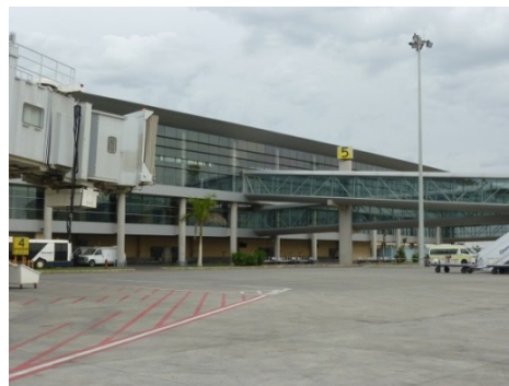
本事業で整備された旅客ターミナル
