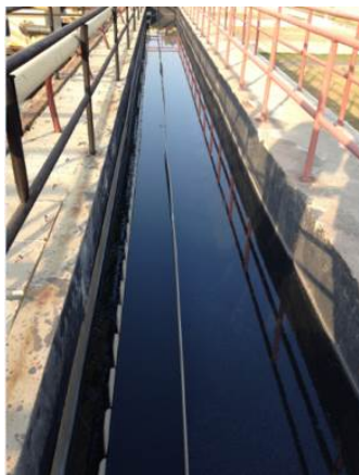
下水処理施設（西部地区）
