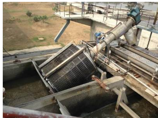
下水処理施設（ケショプール）
