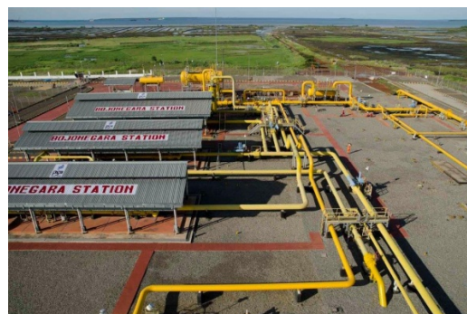
ボジョネガラストーション（チレゴン）
