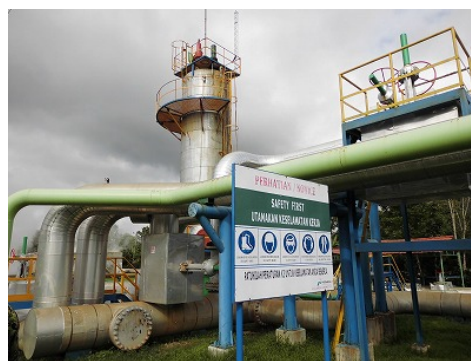
パイプライン交換箇所(23号/28号蒸気井)
