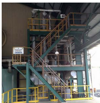
3号機のガス抽出装置
