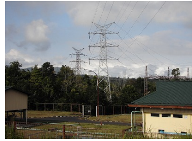
PLN が設置した送電塔 2 基
