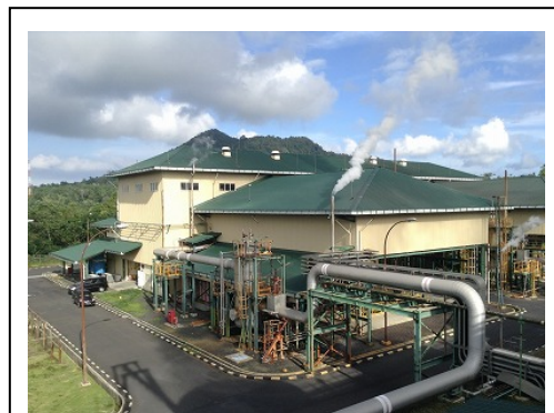
ラヘンドン地熱発電所（外観）
