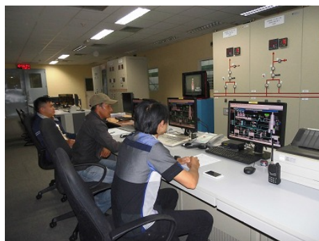
コントロール室
