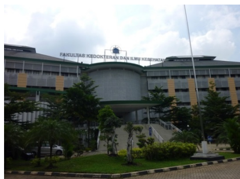
本事業で整備された FKIK 校舎
