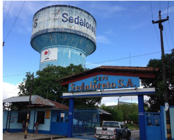
イキトス上下水道公社に建設された配水池
