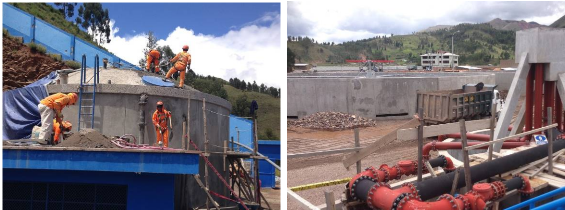
(シクアニ) 建設中の配水池 (左)、下水処理場 (右)
