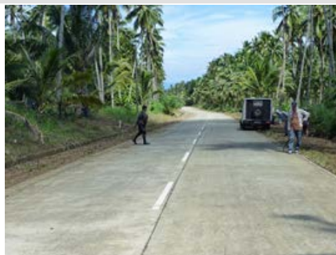
本事業で整備された道路 (カウスワガン～デラバヤン～ムナイ区間)
