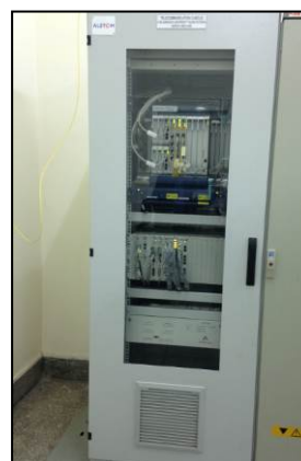
設置された通信システム (イスラマバード大学構内変電所)
