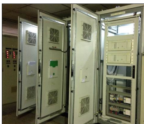
設置された RTU (ラワット変電所)
