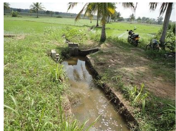
本事業で農民により改修され、現在も農民が維持管理している灌漑水路 (北中部州アヌラーダプラ県)
