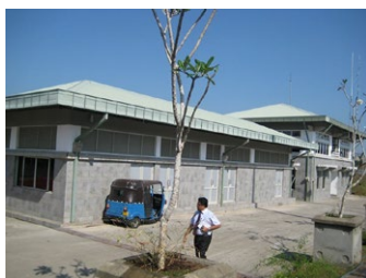
事務所棟（コッタワ料金所）
