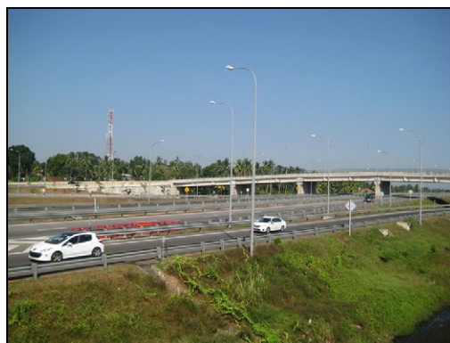
南部高速道路（コッタワ IC 付近）
