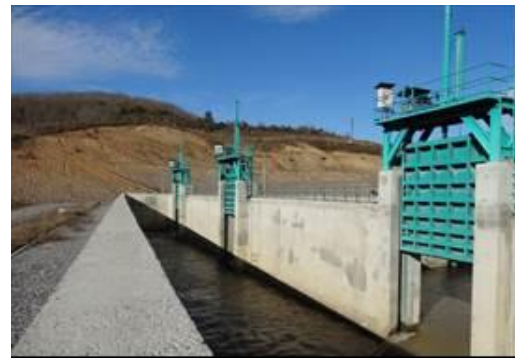
シレコントロールセンター
