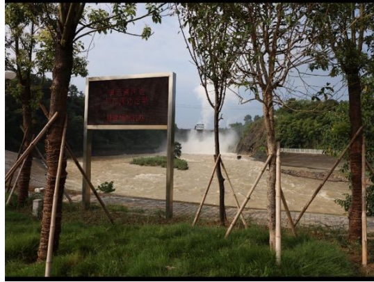
陸水ダム警報電子パネル
