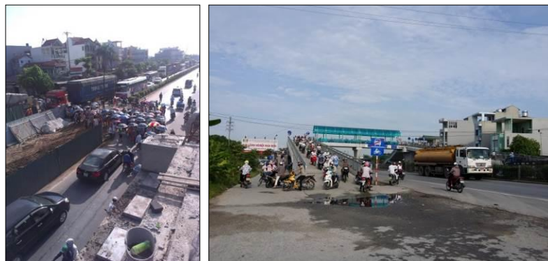
事業実施前(左)と本事業で歩道橋を実施した後(右)の道路状況 注：左は実施機関により提供された写真
