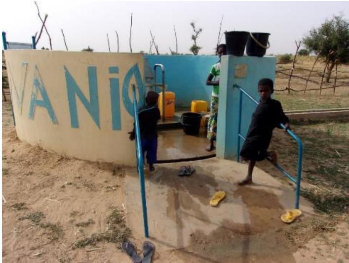
(ティラベリ県バグネイ・コワラ村落のよく管理された深井戸)
